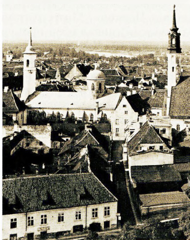
Спасо-Преображенский собор в Нарве (слева). Разрушен в 1944 г. Фотография. Между 1910 и 1914 гг.
