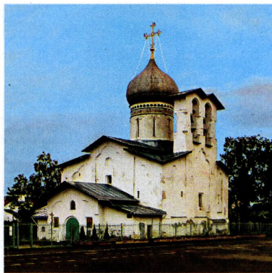
Петропавловская церковь с Буя в Пскове. XVI в. Фотография. 2018 г. Фото З. А. Зверева
