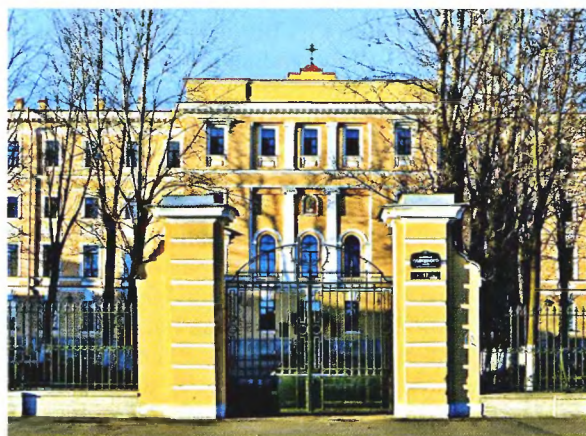
Здание С.-Петербургской Духовной Академии. 1838–1841, 1886–1887 гг. Архитекторы А. Ф. Шедрин, Н. Н. Марков. Фотография. 2014 г.
