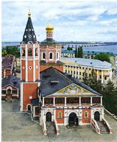
Кафедральный собор во имя Св. Троицы в Саратове. 1697–1710 гг., перестроен в 1798–1799 гг. Фотография. 2015 г. Фото: И. А. Привалов
