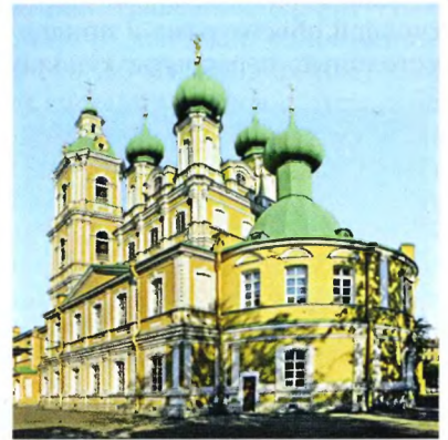
Церковь Благовещения Пресв. Богородицы на Васильевском о-ве в С.-Петербурге. 1750–1763 гг. Фотография. 2019 г. Фото: Ф. А. Зверев
