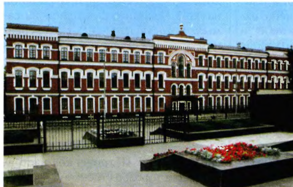
Здание Саратовской ДС. Фотография. 2013 г.
