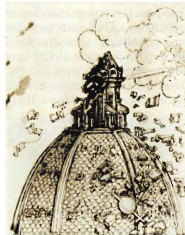
Разрушенные молнией фонарь и купол собора.
